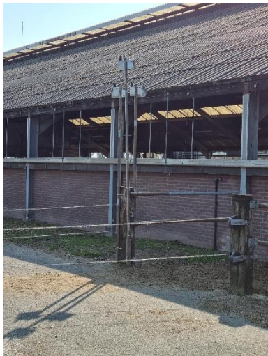
Figuur 10 colocatie bij De Marke
